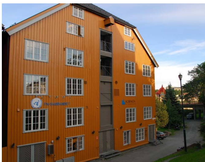
Sjakkbrygga i Kjøpmannsgata 5.
